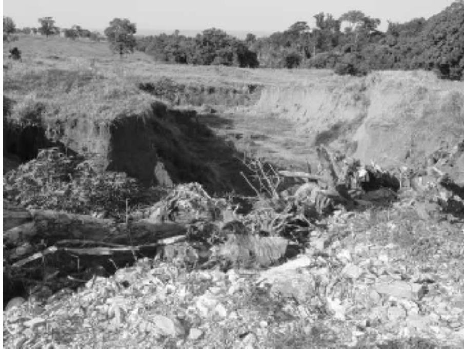
Figura 6 - Voçoroca parcialmente entulhada com materiais dispostos irregularmente sobre área de preservação permanente (nascente).
