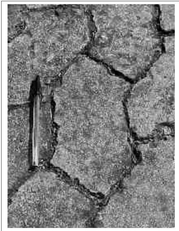
Figura 1: bloquetes utilizados na pavimentação da superfície do solo na Estação de Estudos de Hidrologia do Solo – UNI-BH.
