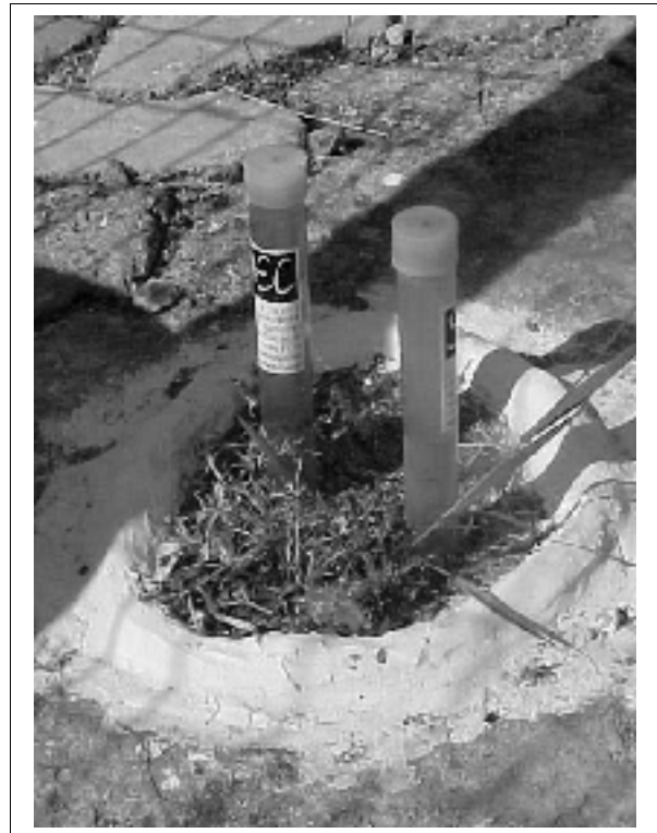
Figura 2: Instalação dos tensiômetros em um dos orifícios abertos com a retirada de bloquete na Bateria 1.
