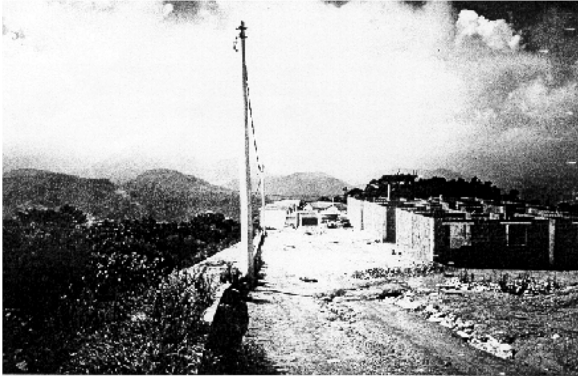
Figura 1 – Fase de Construção do Condomínio Popular. É possível perceber, nas obras, o desmatamento, a compactação do solo, alteração na hidrodinâmica pluvial, processos automáticos de ravinamentos antes da concretagem do solo, os resquícios florestais nas encostas da área, e ao fundo os condomínios da primeira fase da construção.
