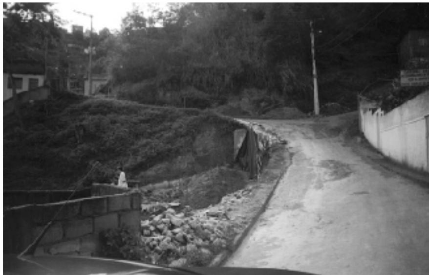
Fotografia 2: Movimento de massa em corte de talude para a construção de casa na porção inferior da rua, no Bairro Alto dos Três Moinhos.
