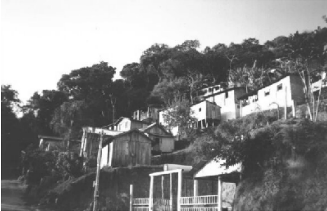
Fotografia 2. Ocupações de áreas de encostas no Morro do Quilombo setor norte da área de pesquisa, causando desmatamento e cortes de terra, proporcionando o favorecimento de instabilizações no terreno.
