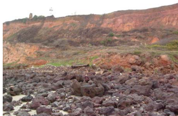
Figura 4: Desagregação de falésia – Ponta do Farol Fonte: Registro da pesquisa rol.
