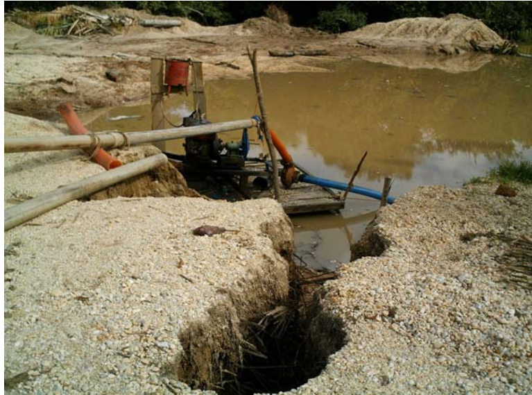
Figura 3 – Draga instalada no rio Munim. Fonte: Ribeiro, 2006.
