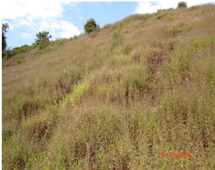
Figura 3 – Encosta que foi decapiada para construção do Colégio de Aplicação da UFV que passou por um processo de recuperação utilizando técnicas de revegetação. Fonte: Os autores, 2006.
