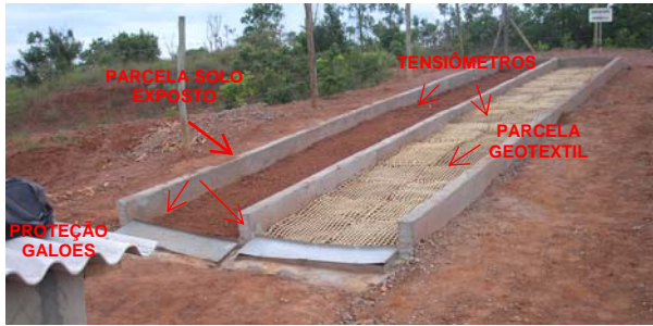
Figura 02 – Estação experimental com solo exposto (SE) e solo com geotêxteis (SG) Autoria: BEZERRA, J.F.R, 18.11.05
