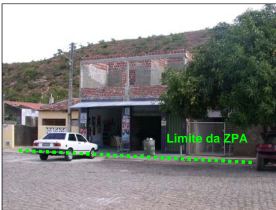
Figura 6 – Edificação para fins comerciais, edificada no interior da área da ZPA-01.
