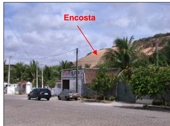
Figura 7 – Oficina e residência construídas em área sob risco de soterramento.
