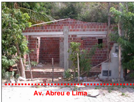
Figura 4 – Edificação, em fase de construção, aracterizando o acelerado processo de ocupação irregular.
