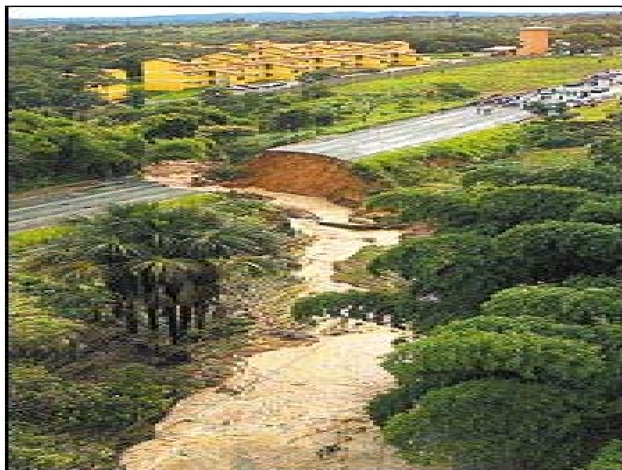
Figura 1 – Cratera aberta na rodovia GO-213
