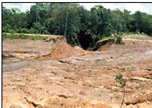
Figura 4 – Represa rompida próximo à área do desmoronamento
