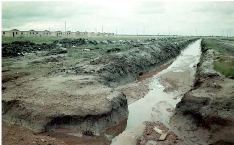
Figura 06. Sistema de drenagem com valas abertas sem qualquer tipo de proteção se constituindo com potencial para erosão urbana e possíveis vetores de doenças.
