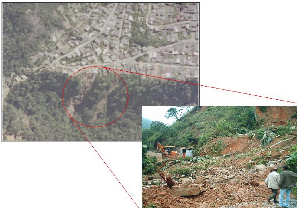
Figura 3. Detalhe de movimentos de massa sem obras de engenharia. (Fonte: Guerra, 2005)
