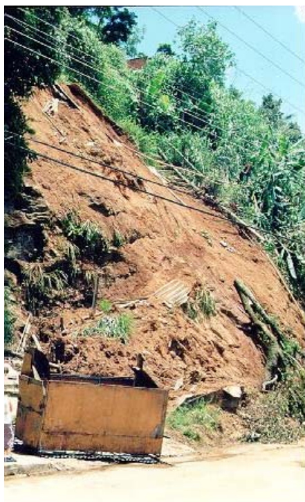
Figura 4: Cicatriz de escorregamento no bairro Dom Bosco
