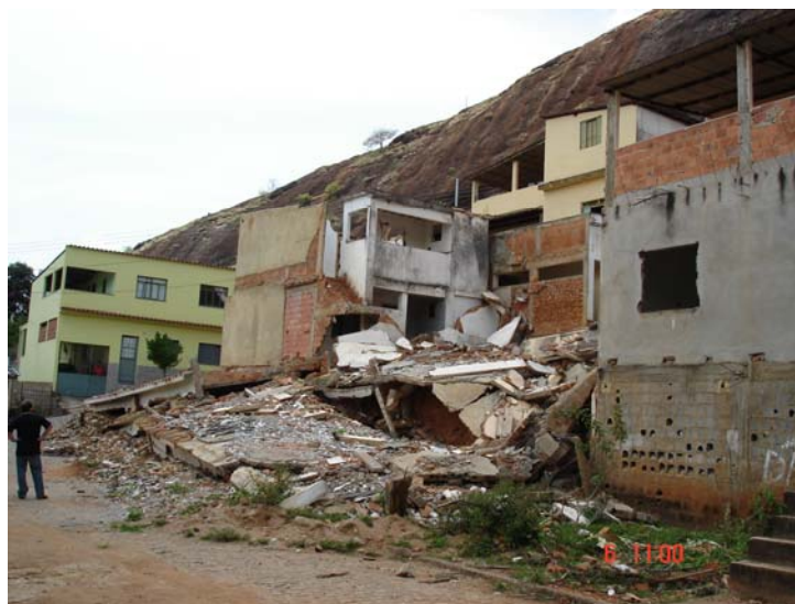
Figura 5 – Desmoronamento de Habitações no Bairro Ninico.
