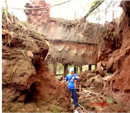
Figura 4: Barreira construída em 1957 para conter a erosão. (F.C.M. Zaparoli, 2005)
