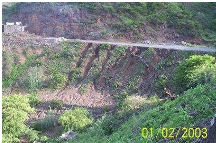
Figura 3 – Deslizamentos de massa (Fonte: CVC, 2003).
