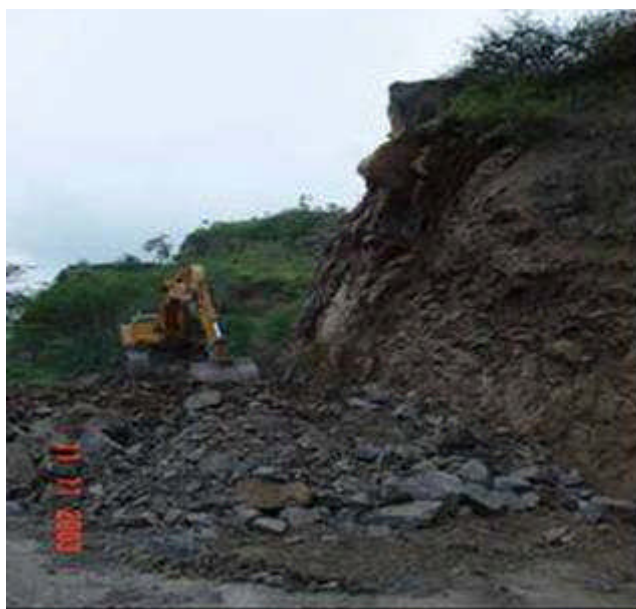
Figura 2 – Desmonte para a ampliação da estrada (Fonte: Os autores).
