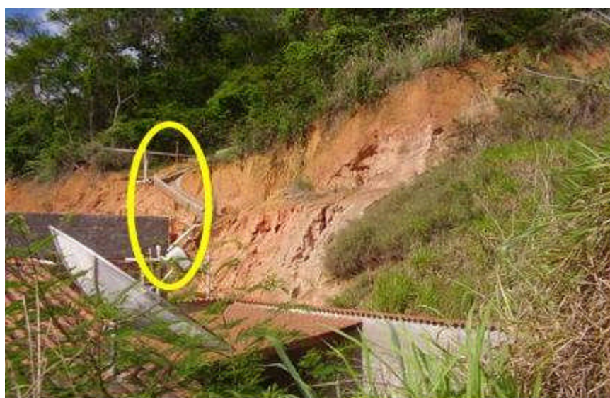
Figura 3. Foto localiza uma encosta do bairro Primavera, com destaque na tentativa de escoar a água na parte superior da encosta.
