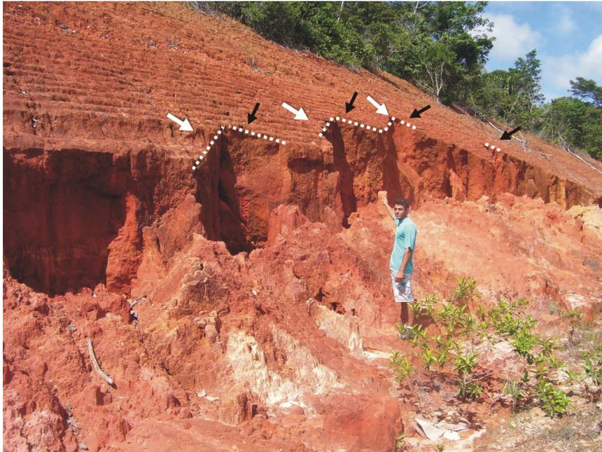
Figura 5- Desmoronamento de encosta a partir de zonas de fraquezas, evidenciando os planos de fraturas indicados pelas setas.
