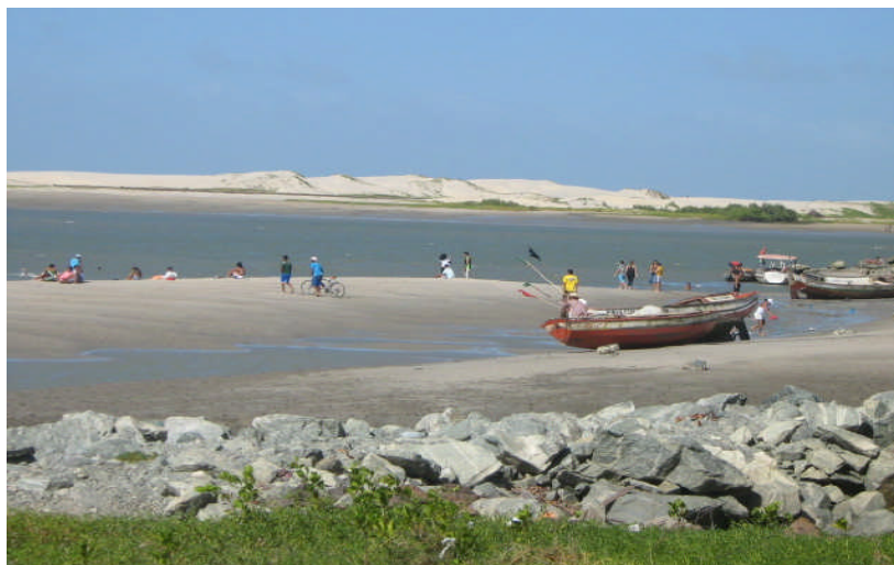
FIGURA 03: Vista parcial do espigão.
