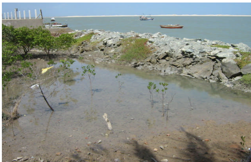
FIGURA 02: Vista parcial do espigão.
