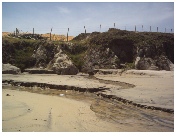
Figura 03 - Presença de córregos oriundo da infiltração da água na Formação Barreiras.
