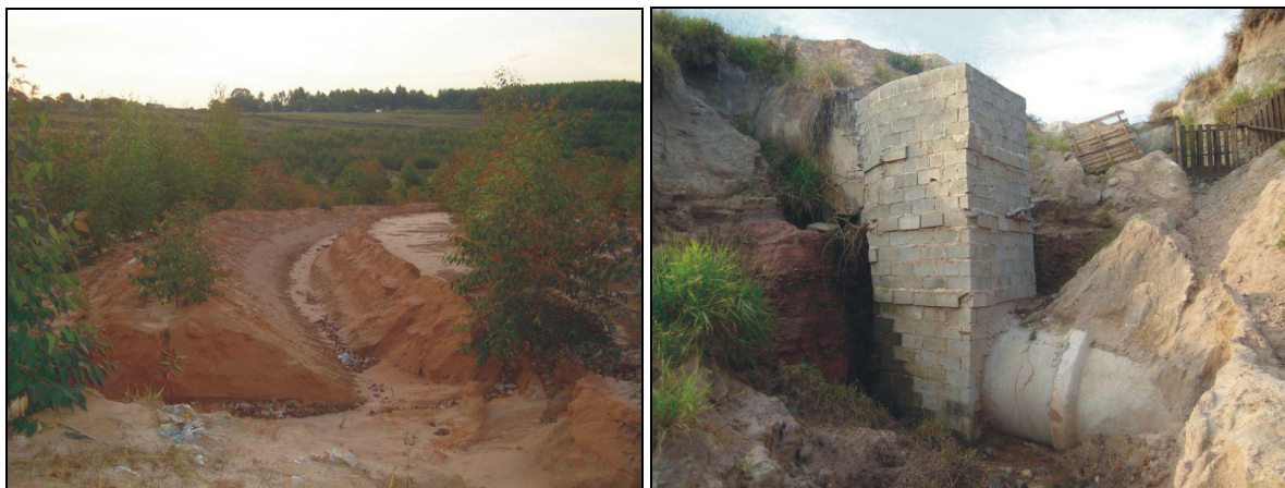
Fig. 04 e 05 – Terraço rompido por sulco erosivo e equipamentos de drenagem pluvial danificados pela reativação erosiva, respectivamente
