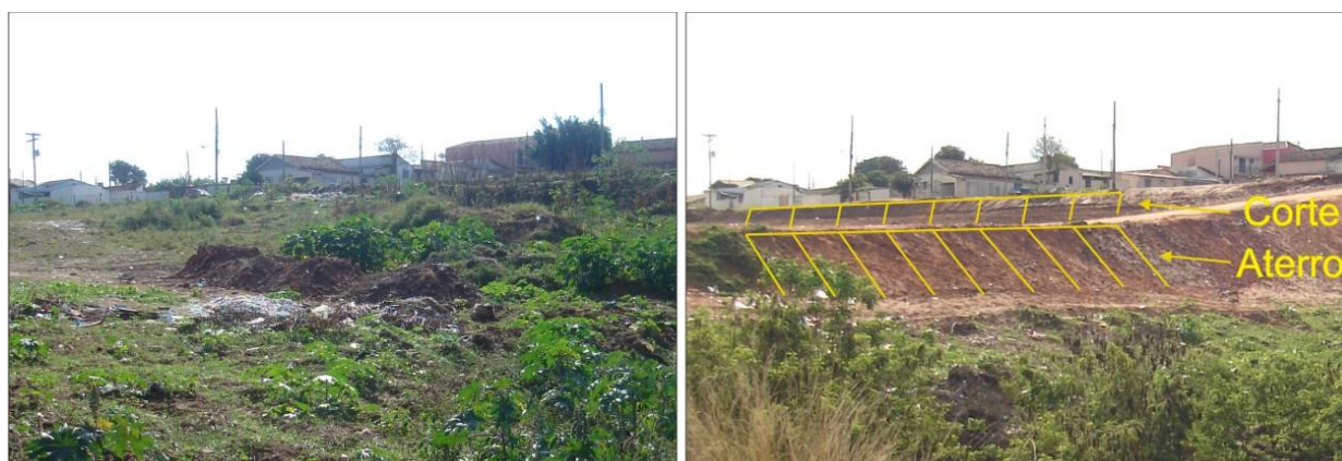
Fig. 02 e 03 – Área de cabeceira do córrego Tucunzinho no ano de 2007 e no ano de 2009, já constando de cortes e aterros, respectivamente
