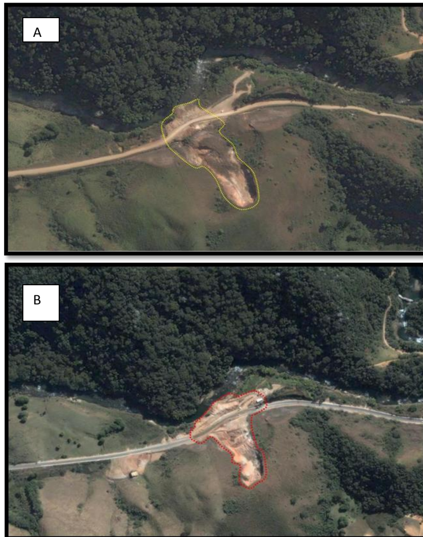
Figura 2: Processos erosivos na encosta conectado ao sistema de drenagem – A) 03/06/2003 C) 22/05/2006. Fonte: Google earth.
