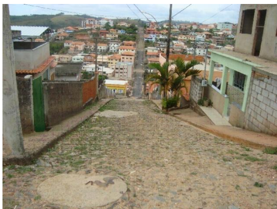
Figura 08: Médio curso do Capão do Melo – Capão Impermeabilização do solo
