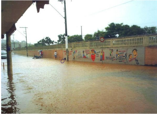
Figura 15: Inundação na Rua Raul Soares Soares
