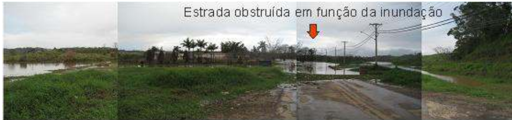
Foto 6: Trecho da estrada do Keida Harada inundada pela represa. Flores (04/2010)
