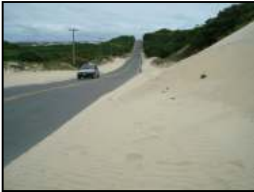
FIGURA 10 - TRECHO DA CE-025 SENDO SOTERRADA PELA AREIA PRÓXIMO A PONTE DO RIO PACOTI. FONTE: PESQUISA DIRETA, 2010
