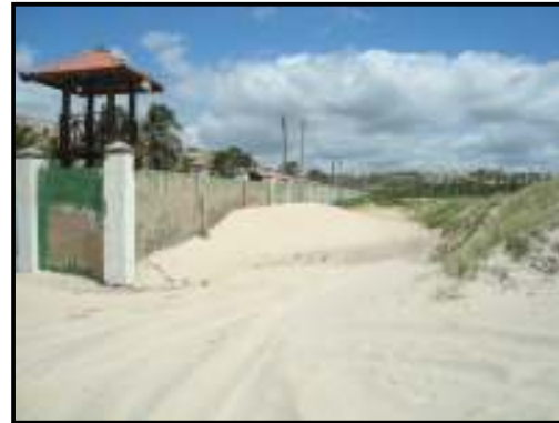
FIGURA 6 - MURRO INTERROMPENDO FLUXO DE AREIA QUE SE ACUMULAM SOBRE VIAS FONTE: PESQUISA DIRETA, 2010
