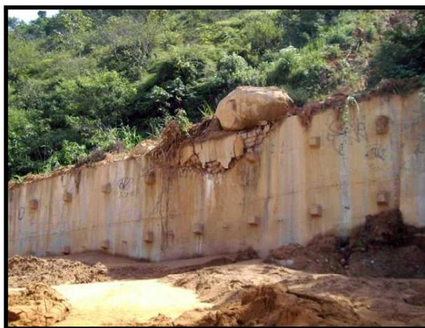
**Fig. 8 - Movimentos gravitacionais de massa com queda de blocos afetando diretamente o muro de contenção existente na rodovia BR-101 e causando interdição parcial da estrada. Fotografia: E.A.L. Pocidonio (abril/2010).**
