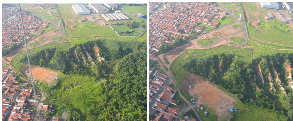
Fig. V: Vista aérea da Voçoroca da Mãe Preta. FONTE : EDMILSON LIMA (2005)
