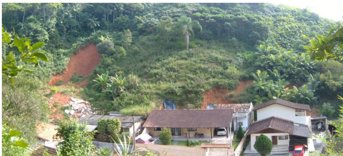
Figura 8 - Vista parcial da encosta norte da Rua União da Vitória. A esquerda da foto observou-se um escorregamento rotacional que destruiu duas casas e do centro para a esquerda uma crista de ruptura de um grande escorregamento (ativo há anos segundo moradores) que ameaça as residências. Foto: Harideva M. Égas, junho de 2009.
