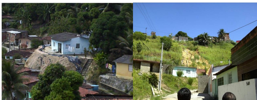
Fig.1 – Ocorrência de processos erosivos nas encostas em Lagoa Encantada. Fonte: Cavalcanti, 2009.
