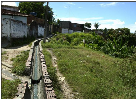
Fig. 4 – Vala de drenagem coletora de efluentes domésticos. Fonte: Gomes, 2009.
