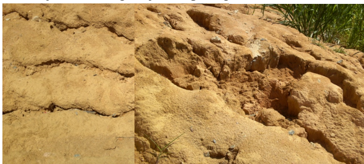
Fig. 6 – Vista parcial do início de ocorrência de voçoroca e ravinas. Fonte: Cordeiro, 2009.
