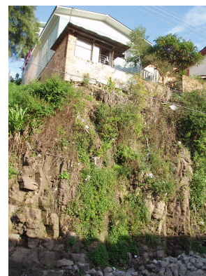
Figura 08 – Situação 2 representada por blocos de rocha instáveis.
