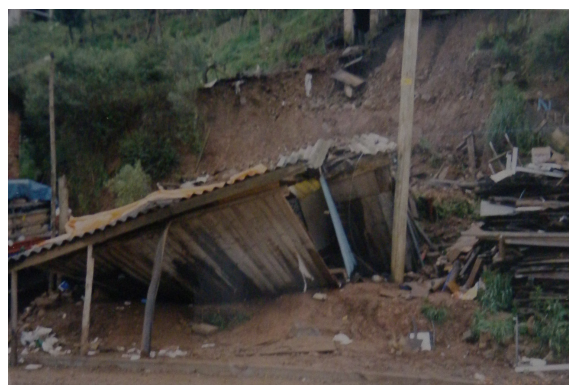
Figura 10 – Situação 4 representada à esquerda por um esquema onde observa-se solo/material de alteração em contato direto com a rocha e apresentando mergulho no sentido do corte. Ao lado direito apresenta-se uma fotografia com cicatriz de escorregamento (foto: PREFEITURA MUNICIPAL DE CAXIAS DO SUL, 2000).
