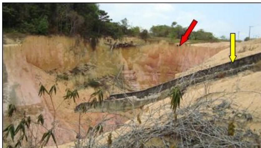
**Fig.5 - Vista em direção a montante da voçoroca 9. Seta vermelha aponta para saída d'água na forma de tubos de 100 mm de diâmetro. Seta amarela aponta para a mesma canaleta da foto 6. Distrito Industrial 2 – Manaus (AM). Foto de Antonio F.G. Vieira (12/09/09).**
