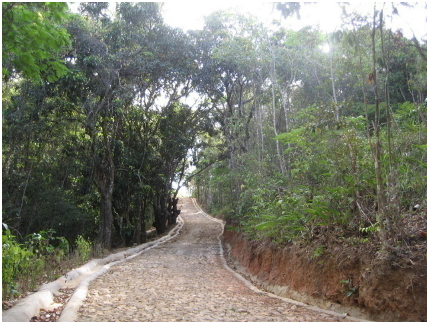
Desmatamento para a implantação de via de acesso interna à residência unifamiliar na APA da Serra de Baturité. Fonte: Doris Day Santos da Silva, 2011.
