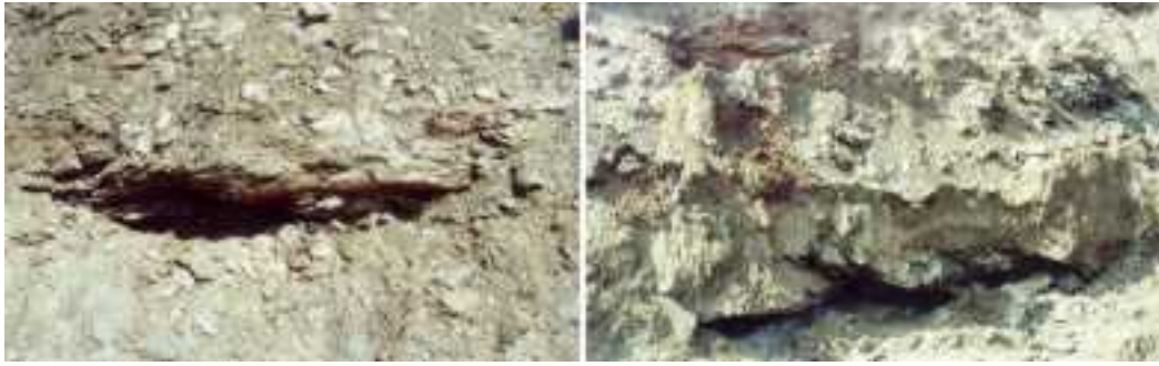
Figura-10 – Após a conclusão da terraplenagem, confirmou-se a existência de um pequeno conduto.
