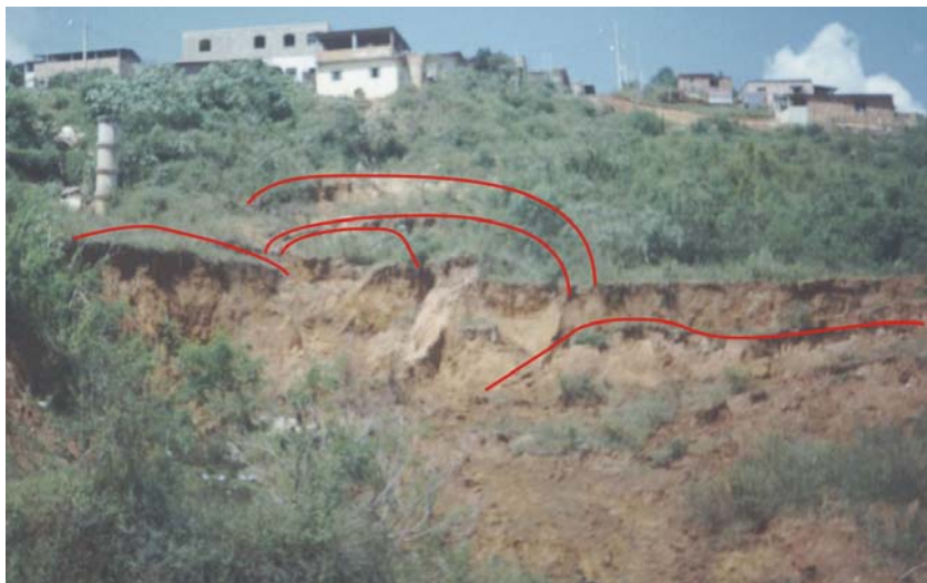
Figura 5- Escorregamento rotacional próximo à residência.
