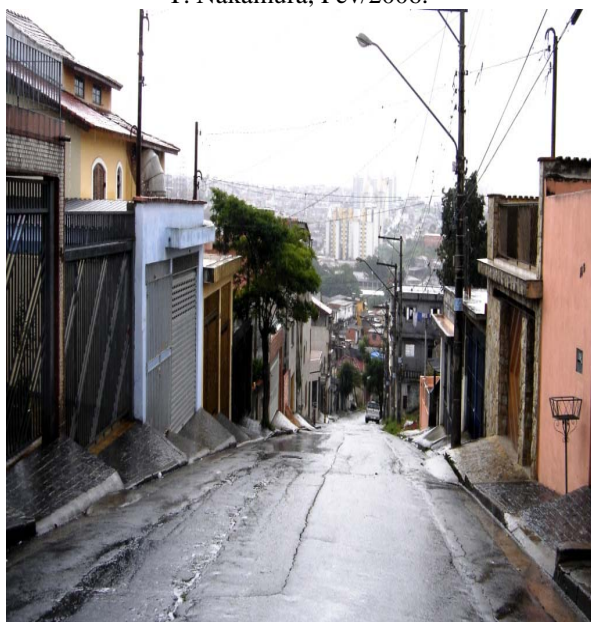
Figura 5: Ponto 6. O conjunto formado pelos elementos urbanos, edificações, calçadas em aclive e vias pavimentadas, formam verdadeiras calhas para a concentração águas pluviais. Eduardo T. Nakamura, Jan/2006.
