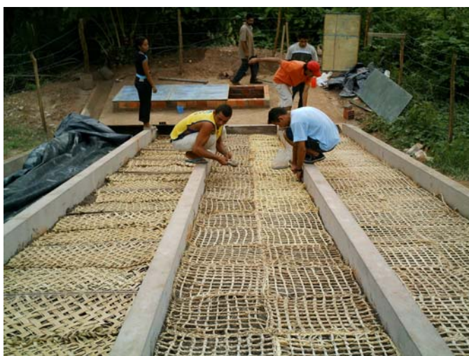
Figura 3 – Implantação das geotêxteis
