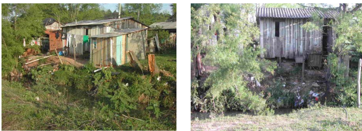
Figura 4: Moradias situadas nas margens do arroio Cancela e sujeitas a processos de inundação e de erosão de margem.
