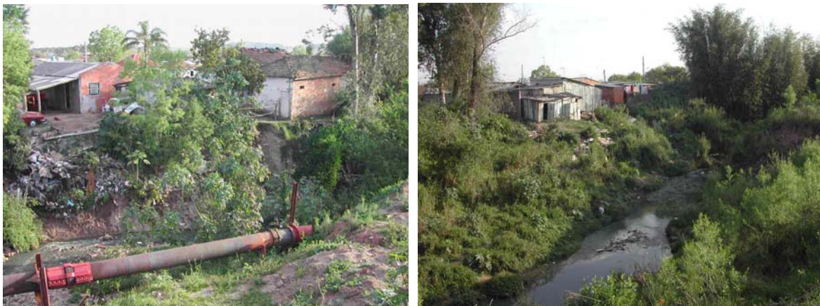
Figura 5: Moradias situadas nas margens do arroio Sanga do Hospital, que teve seu leito alargado e aprofundado devido a reativação dos processos de erosão de margem.
