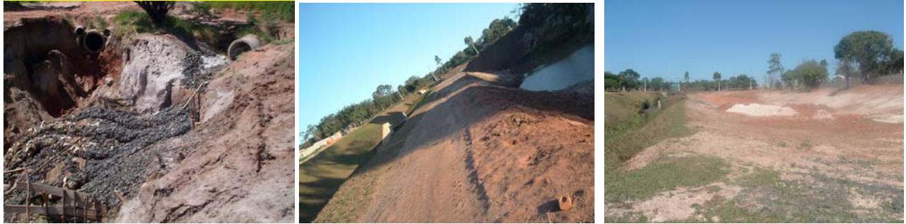
Figura 8: Erosão da Chácara Odete respectivamente em 2004 sem dissipadores de energia, em 2005 com galeria de esgoto à esquerda e formação de uma grande lagoa à direita e, em 2006 com a lagoa aterrada
