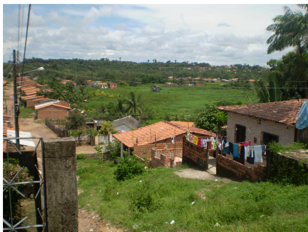
FIGURA 3: Rua Maria da Paz – avanço das construções em área de manguezais.
