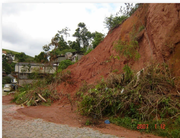
Foto 01: Deslizamento de encosta no distrito de Riograndina, em janeiro de 2007 (Foto: da autora)
