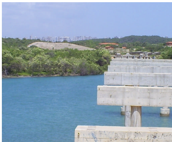
Figura 03: Ponte em andamento e desmatamento do mangue à esquerda.
