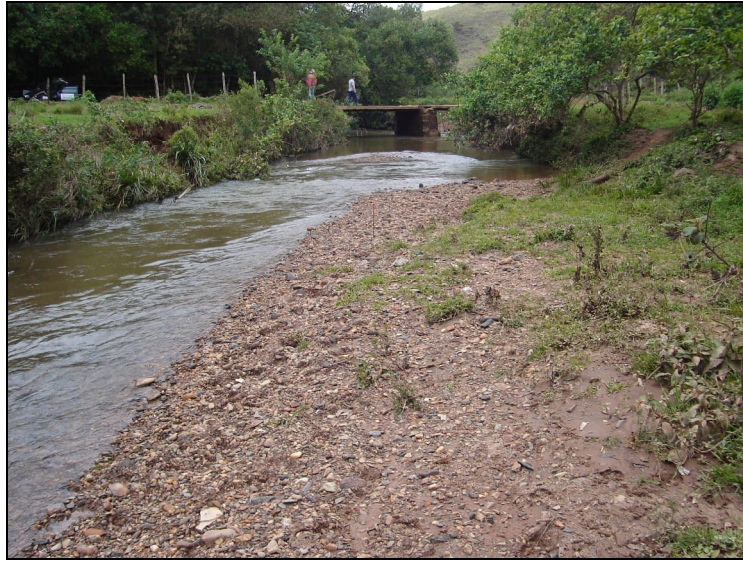
Figura 4 – Foto de barra de canal detrítica em ponto de encouraçamento da calha e corredeira
