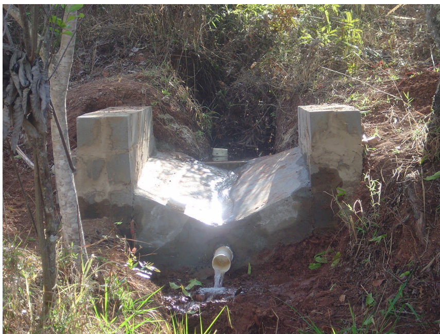
Fig. 3 – Vertedouro para medição de saída de sedimentos na foz do canal da voçoroca.
