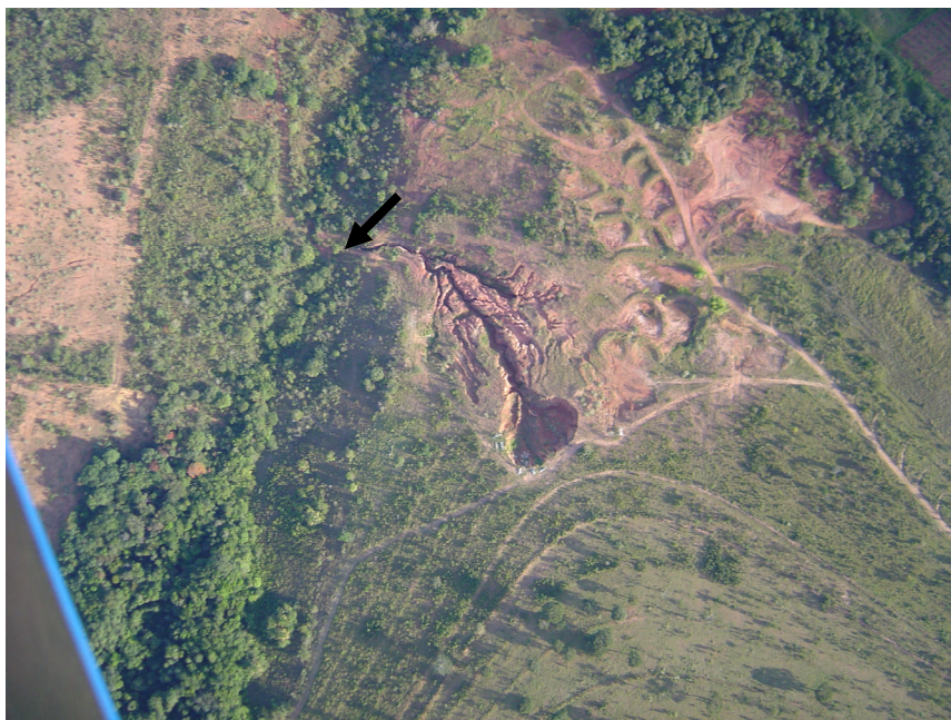
Fig. 2 – Área da voçoroca estudada. Observe a grande quantidade de canais menores conectadas ao canal principal. A seta indica a posição em que a voçoroca se conecta à rede de drenagem. Fonte: ALVES, 2004 – Trabalho de campo.
