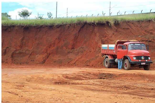
Fig. 04: Cobertura pedológica tipicamente encontrada na área do Distrito Industrial, resultante da alteração dos calcissiltitos, calcarenitos e margas pertencentes ao Membro Pedro Leopoldo, da Formação Sete Lagoas. É digna de nota a considerável espessura dos solos, bem como o fato da rocha sã não ter sido alcançada em corte de talude com cerca de 8 metros de profundidade. (Fotografia obtida em 02/04/2008, em corte de desaterro localizado à Rua Zico Barbosa, s/n).
