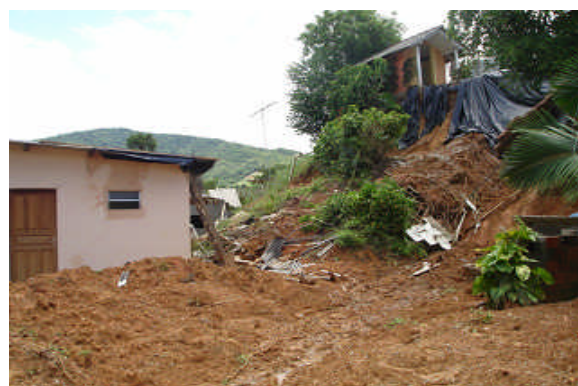
Figura 03: Deslizamento em um corte com degraus mal dimensionados, que danificou a estrutura da casa e ocasionou o entulhamento da residência a abaixo (Foto: Rony Ramos, 01 de fevereiro de 2008).
