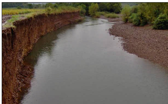
Figura 4: Erosões e assoreamento do canal.
