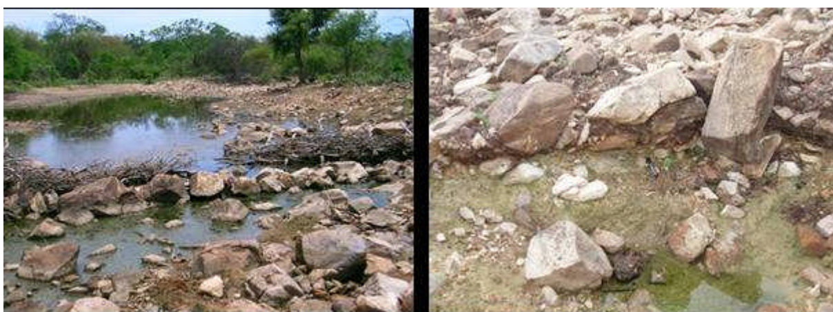
Figura 9 – barragem de pedras e cerca de galhos rompida; Figura 10 – cascalheira de leiro “encouraçada” ( armoured ) por cimentação ferruginosa.
