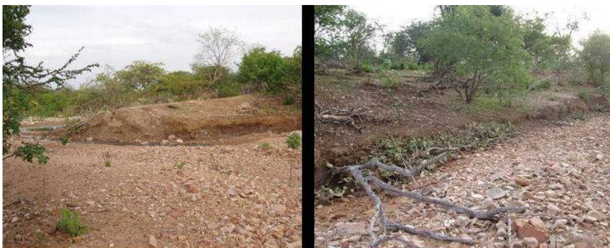
Figura 11 – Barragem rompida no setor semi-confinado formando terraço desconectado do leito; Figura 12 – Subida no nível de base no canal contíguo a uma barra longitudinal cascalhosa a montante do barramento..
