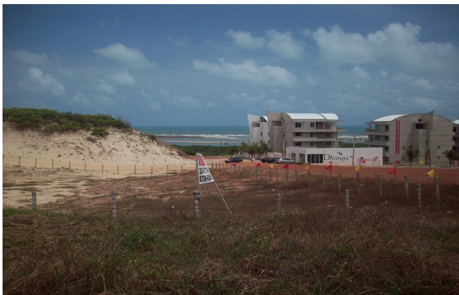
Fig. 2 - Construção de condomínio em campo de dunas semi-fixas.
