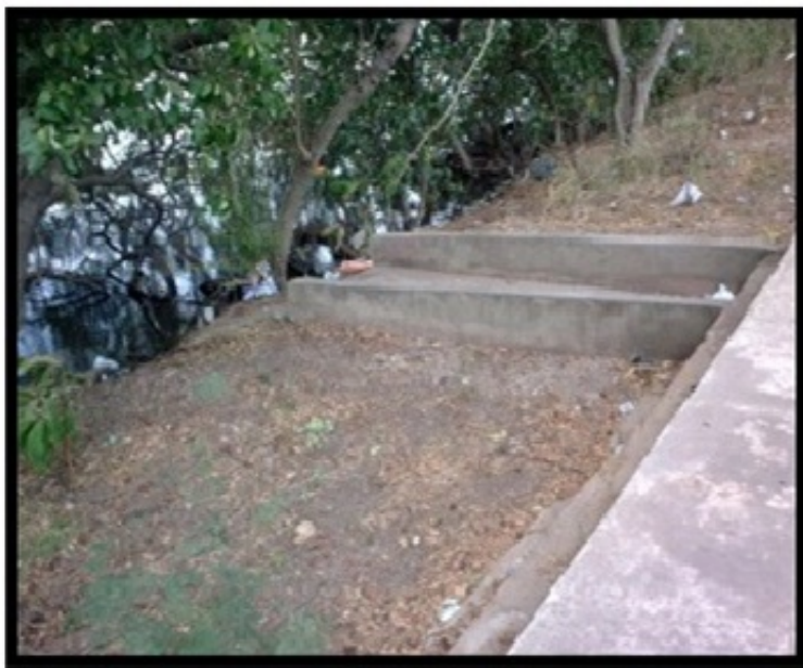
Problemas sanitários ao entorno da Laguna do Bacanga
